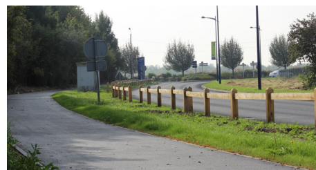
Séparation via aménagement paysager et lice en bois - SIZIAF, Billy-Berclau
