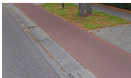
La piste cyclable ne s'abaisse pas au niveau de chaque accès privatif. Source : « Guide des aménagements cyclables », Paris en Selle, 2019
