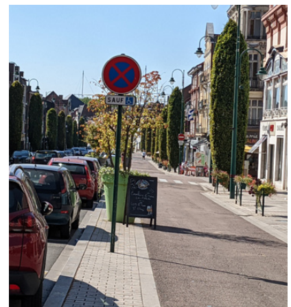
Piste cyclable bidirectionnelle séparée de la chaussée par une bande fonctionnelle (stationnement et mobilier urbain).
