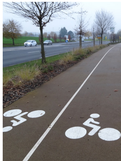
Séparation par un aménagement paysager
