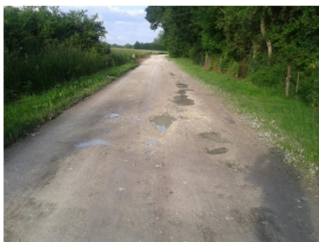
Dégradation d'un revêtement stabilisé
