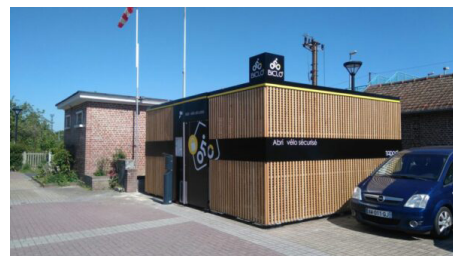
abri vélos sécurisé, Bully-Grenay
