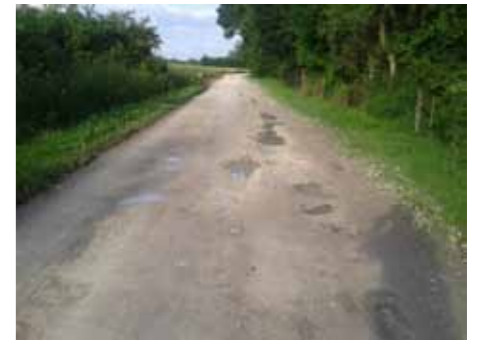
Dégradation d'un revêtement stabilisé
