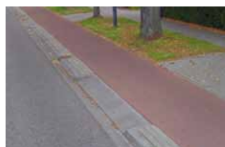
La piste cyclable ne s'abaisse pas au niveau de chaque accès privatif. Source : « Guide des aménagements cyclables », Paris en Selle, 2019
