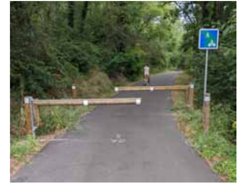
Dans le cas d'une chicane, il faut privilégier un espacement de 3 à 5 m entre les obstacles.
