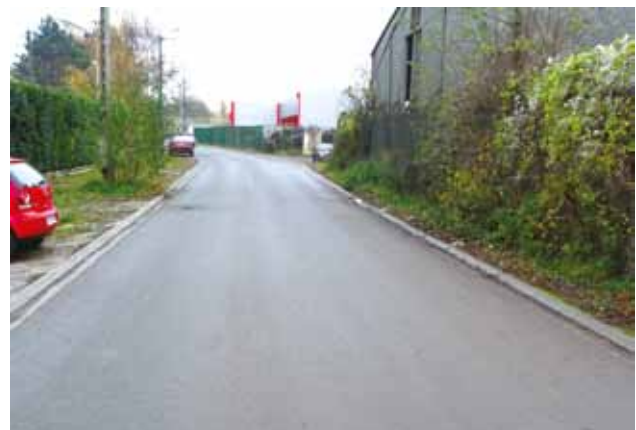
Absence de trottoirs aménagés sur la rue du Marais
