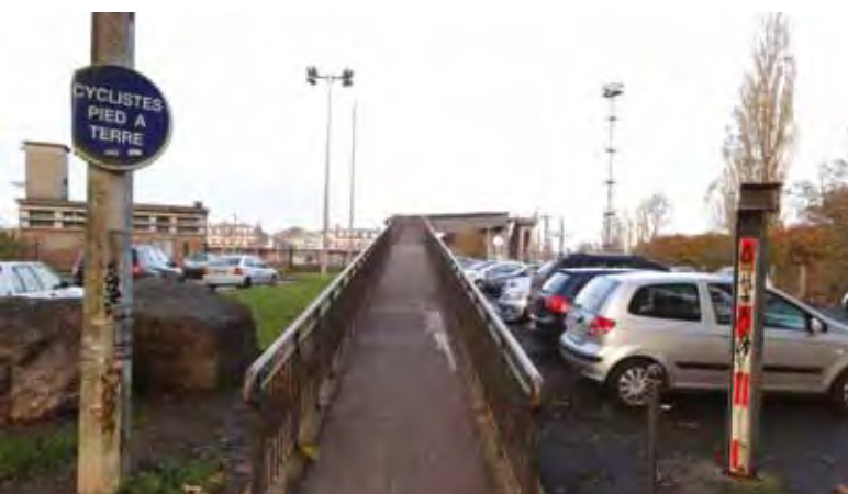
Passerelle permettant d'accéder à la gare depuis le secteur au Sud des voies ferrées
