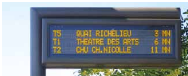
Exemple d'information dynamique en station
