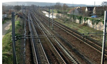
Infrastructure ferroviaire: source : Montils et Bussac-sur-Charente
