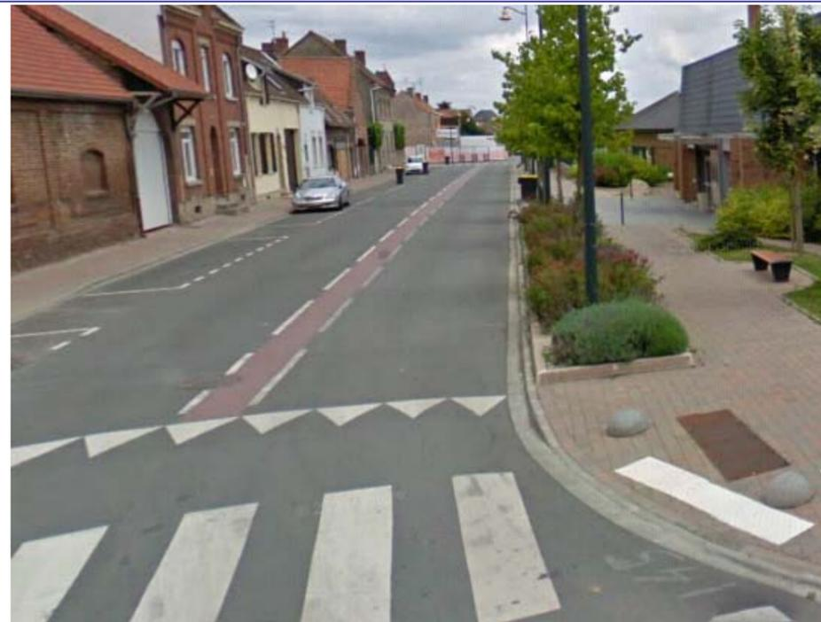
Plateau en carrefour et rétrécissement de la bande roulable au droit de l'école d'Hulluch.
