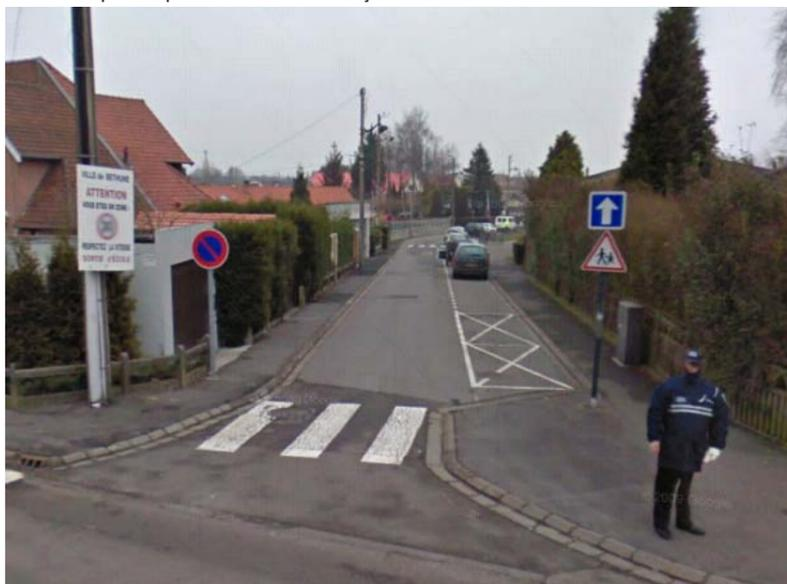
Exemple de délimitation des abords d'école : rétrécissement de chaussée aux traversées, mise à sens unique de la voie et stationnement, signalisation verticale (A13a et « sortie d'école ») à proximité de l'école Buisson à Béthune.
