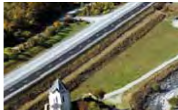
Infrastructure et paysage, source : le temps du bilan
